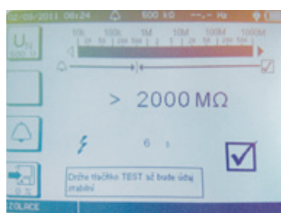
■ Obr. 6 Obrazovka přístroje po naměření izolačního odporu
