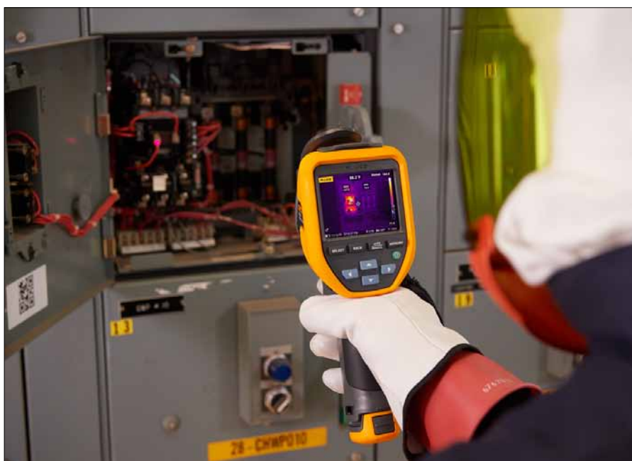
Obr. 3. Provádění údržby s kamerou Fluke TiS75+
